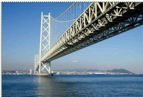
写真-7 明石海峡大橋（淡路島側から撮影）
