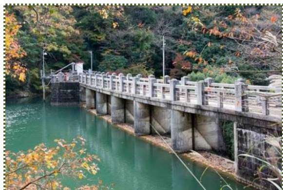
写真-2 猪鼻ダム洪水吐を上流側から撮影
