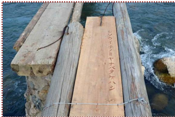
写真-7 番線で結束された桁
