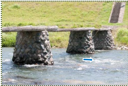
写真-6 現在のコンクリート製の橋脚
