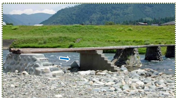
写真-9 流れ橋の橋脚
