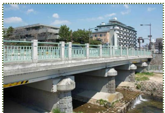
写真-12 大正14年に竣工した業平橋
