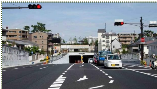
写真-19 山手幹線・芦屋川隧道
