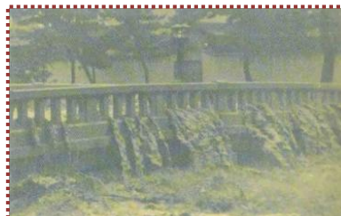
写真-15 阪神大水害で月若橋を越える濁流 （『精道村のあゆみ』から引用）
