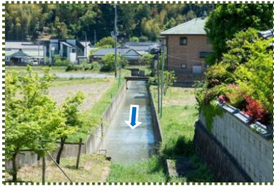
写真-4 母坪地内に開削された排水溝
