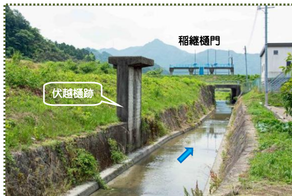
写真-8 藤室川と藤グロ伏越樋跡
