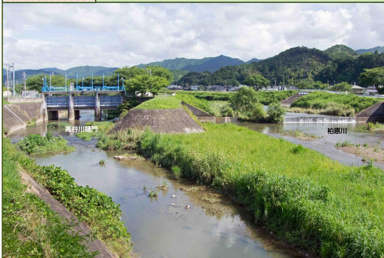
写真-1 国道 175 号・小橋側道橋から柏原川と高谷川を撮影（平成 30 年 7 月）
