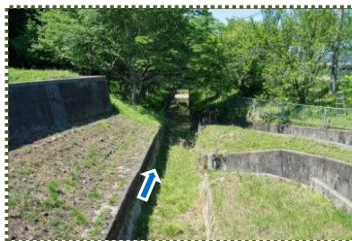
写真-5 猪の山裾に開削された排水溝
