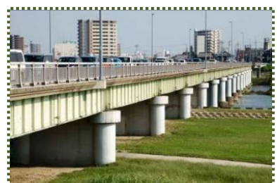
写真-4 国道2号加古川橋
