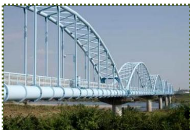
写真-2 加古川水管橋
