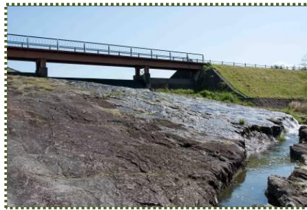
写真-4 露岩地に設けられた洪水吐
