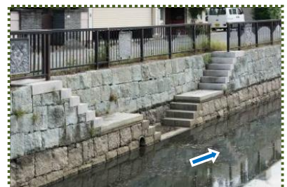
写真-7 加里屋川護岸整備で復活した雁木
