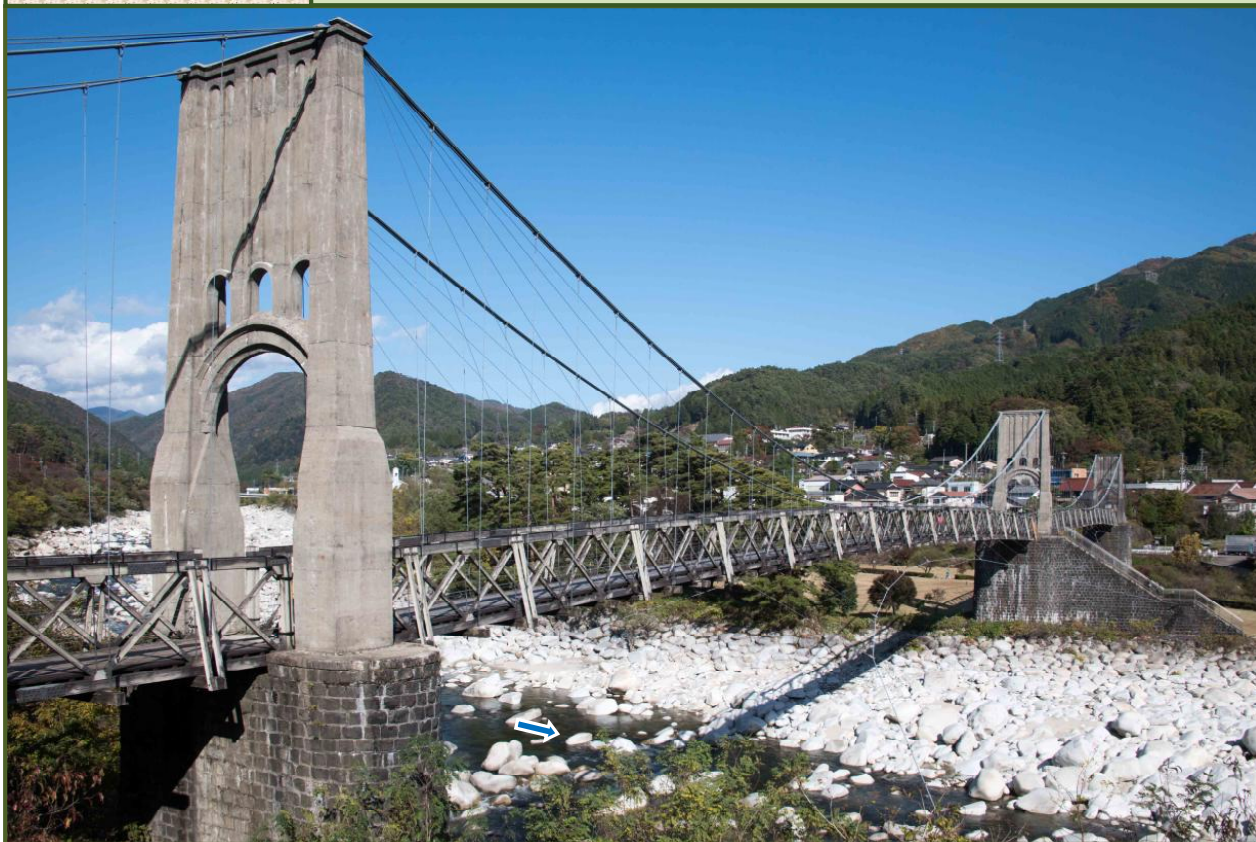
写真-1 木曽川に架かる桃介橋（令和2年11月撮影）
