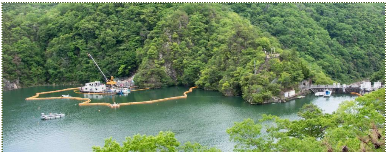
写真-10 千苅貯水池ハイキングコースから千苅ダム治水活用工事現場を撮影（令和 2 年 5 月）
