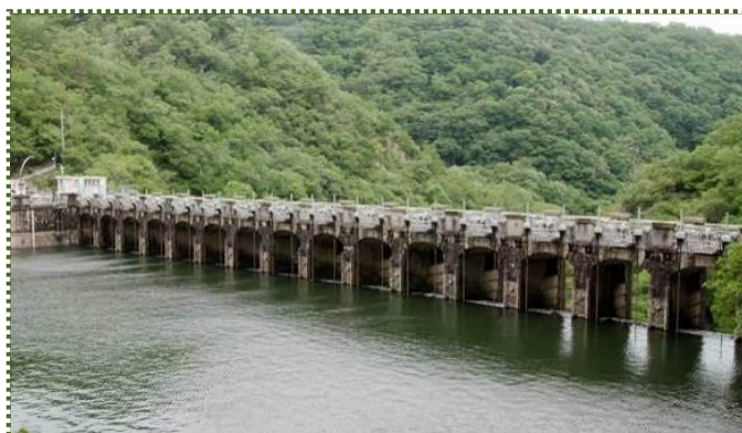
写真-2 上流側から千苅堰堤の越流部を撮影
