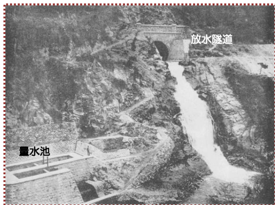
写真-7 千苅放水隧道出口および貯水池（大正8年4月19日撮影）
