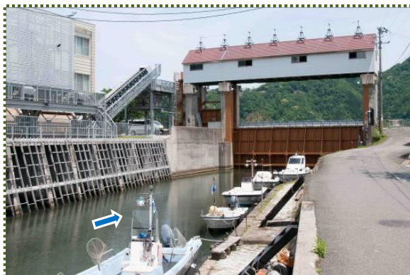
写真-4 大谿川河口の城崎水門
