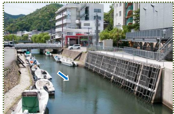
写真-5 右の建物が城崎排水機場
