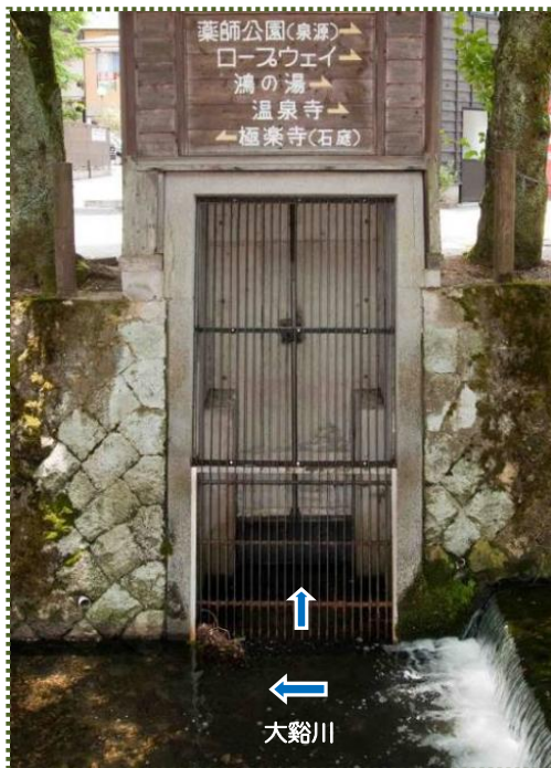
写真-3 導水樋門
