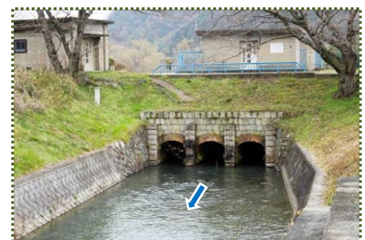
写真-3 飾磨樋門（船場川の上流端）
