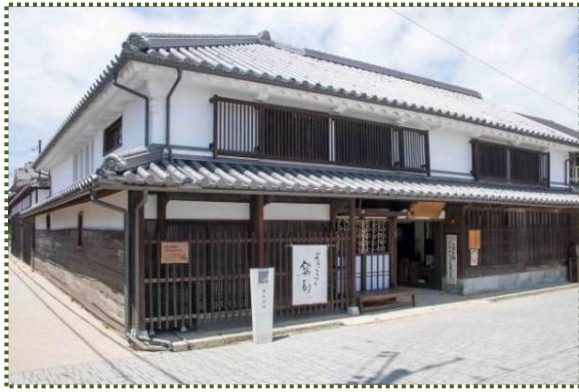
写真-7 保存修理後の工樂松右衛門旧宅
