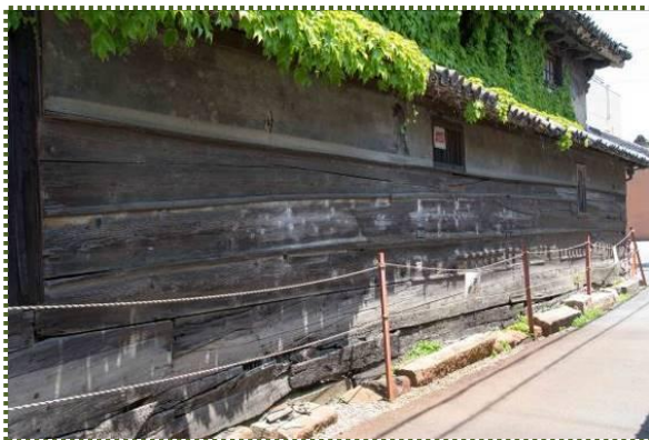
写真-5 舟板を使用した妻壁（工楽松右衛門旧宅・平成 26 年 5 月）
