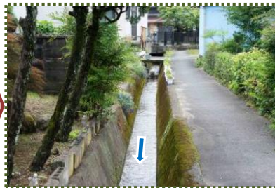
写真-7 祇園社付近の排水路
