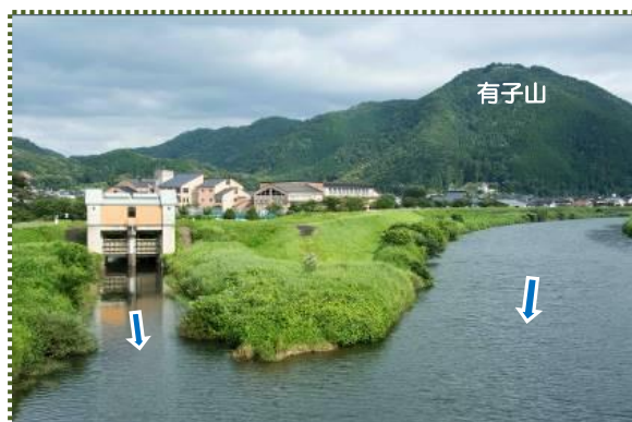
写真-3 出石鶴見橋から出石川と谷山川の合流部を撮影
