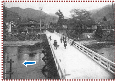
写真-12 明治 43 年完成の木造の出石大橋 （『柳町今昔物語』から引用）
