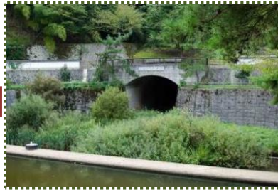
写真-16 放水路呑口
