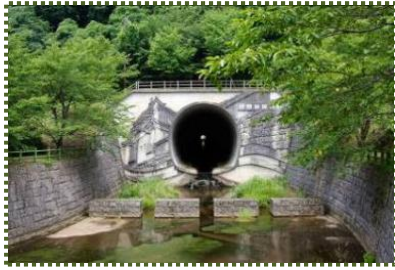
写真-15 放水路吐口とバップルピアによる減勢工
