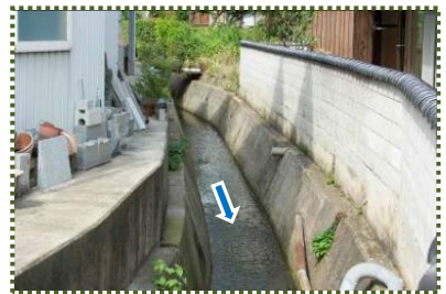
写真-9 県道宮津養父線から上流を撮影
