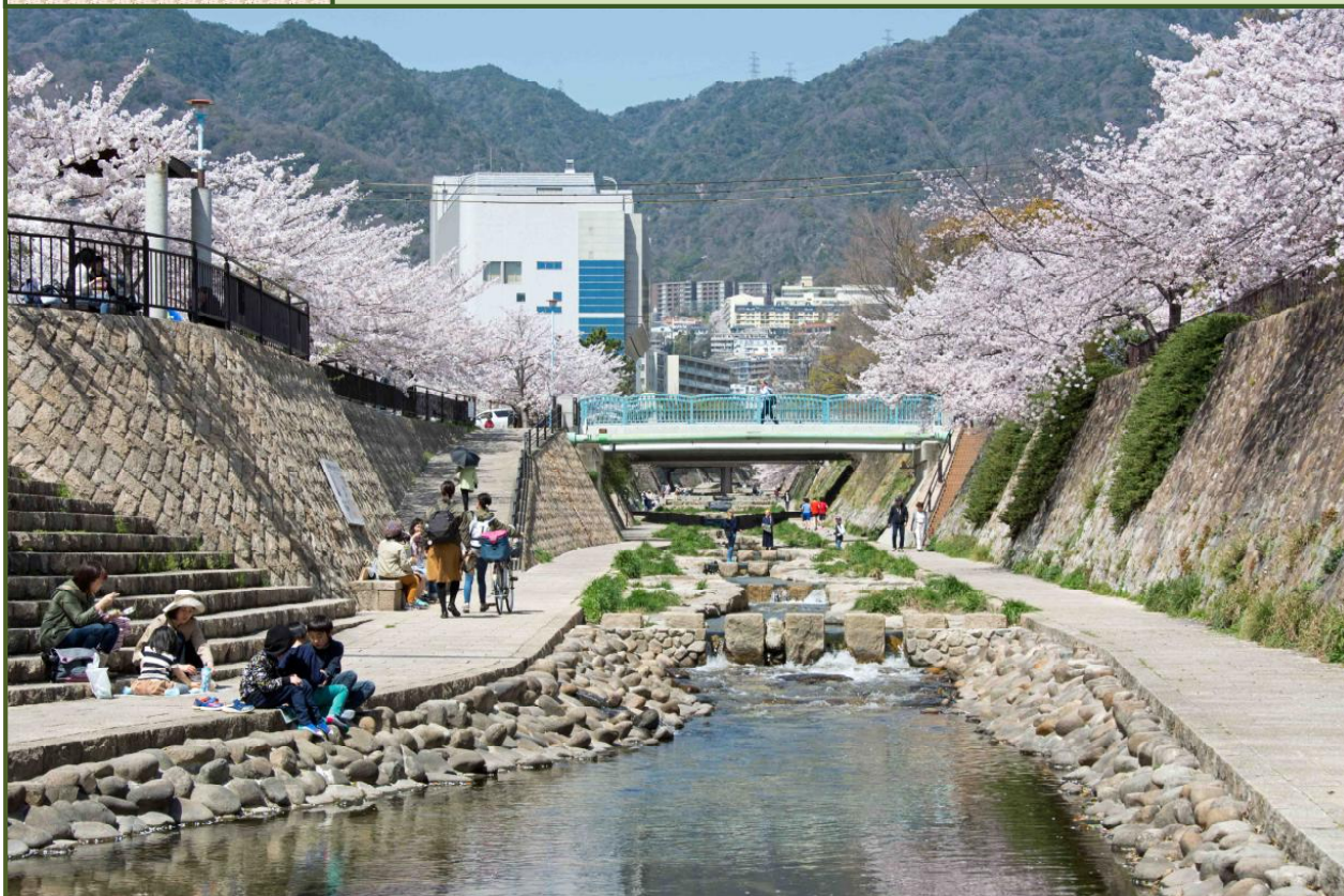
写真-1 JR 都賀川橋梁付近から上流を撮影（平成 30 年 3 月）
