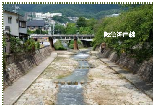
写真-5 阪急電鉄・神戸線下流を流れる都賀川
