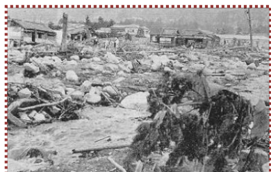
写真-2 水害直後の篠原中町付近 （『六甲山災害史』から引用）
