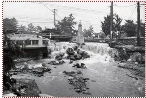
写真-10 阪神国道・住吉橋付近の惨状 (神戸市HPから引用)
