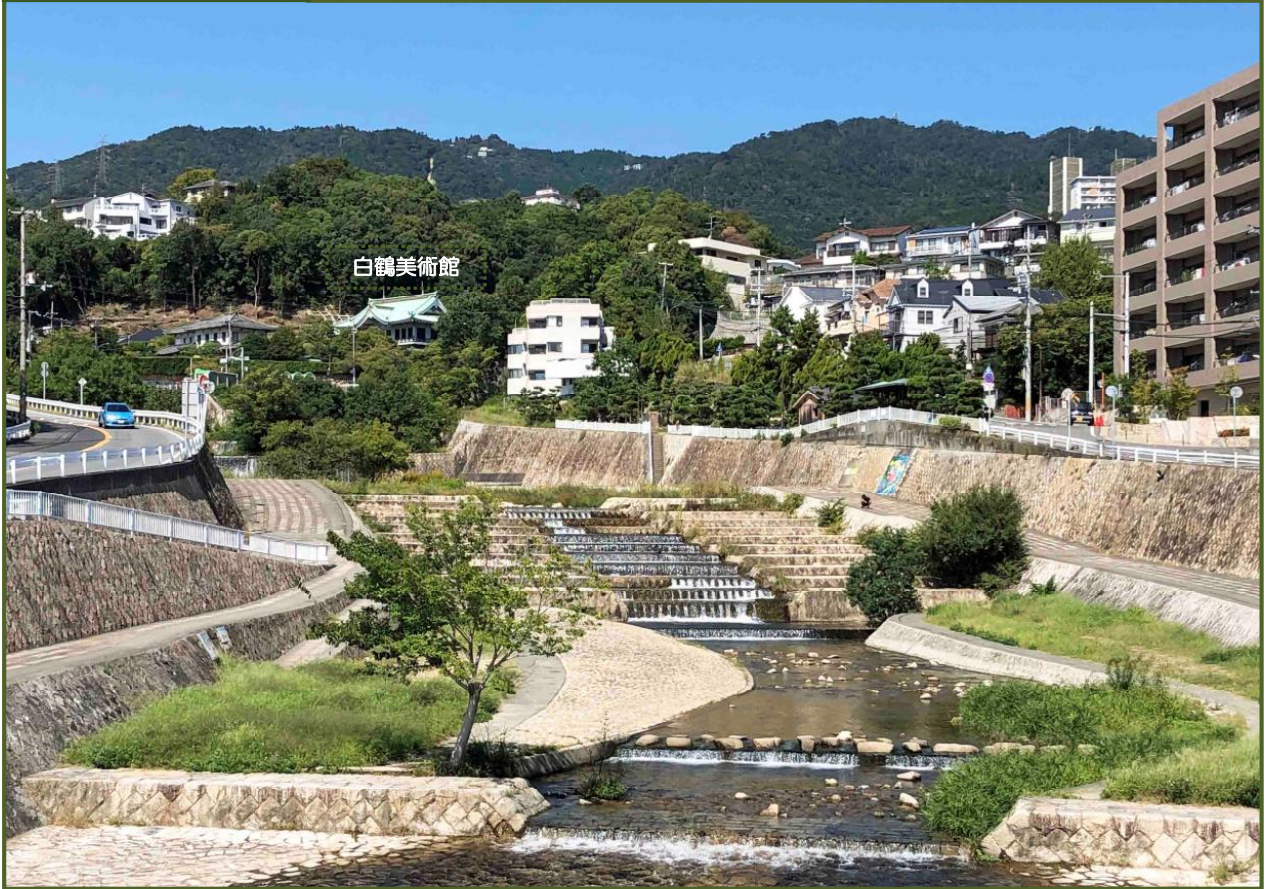
写真-1 新落合橋から住吉川上流を撮影（令和元年10月）
