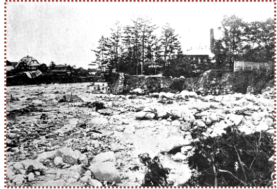
写真-8 危険な状態の野村邸北部川岸 (神戸市HPから引用)
