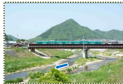
写真-10 野間川に架かる JR 板波川線橋梁
