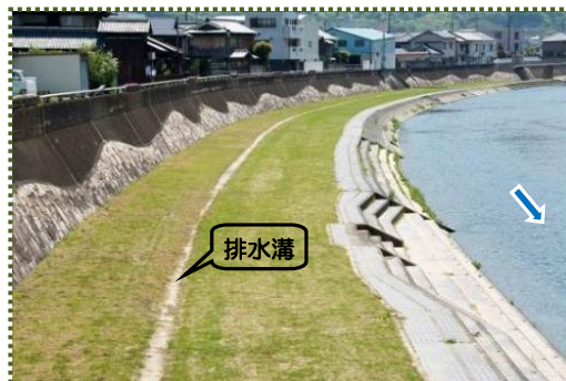
写真-7 杉原川の高水敷に設けられた染色排水用の排水溝
