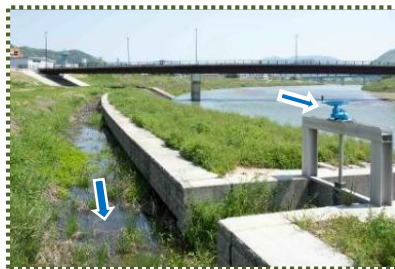
写真-9 地下水位維持のために設けられた堤外水路
