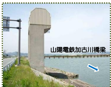
写真-3 昭和 57 年完成の現・高砂樋門
