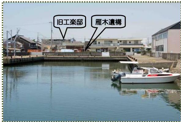
写真-13 南堀川西端部の向こうに保存工事中の旧工楽邸が見える
