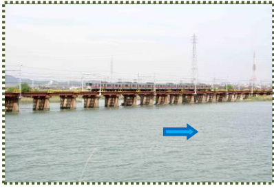
写真-6 山陽電鉄加古川橋梁 (この直下流に旧国鉄高砂線の橋梁があった)
