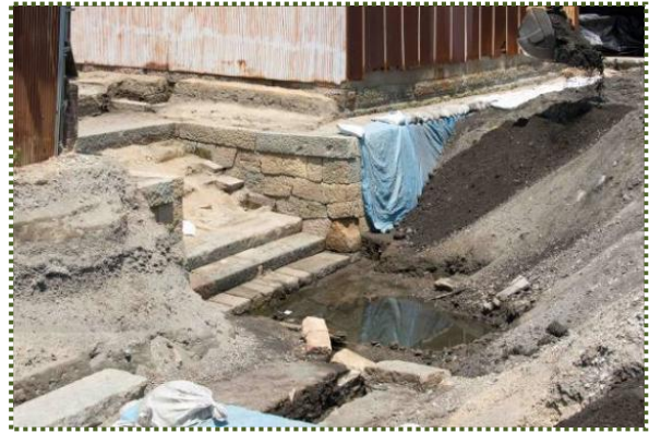
写真-14 南堀川の西において雁木や石垣が確認された遺構
