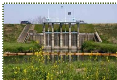
写真-4 洗川樋門
