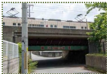
写真-12 橋上は伊保駅ホーム
