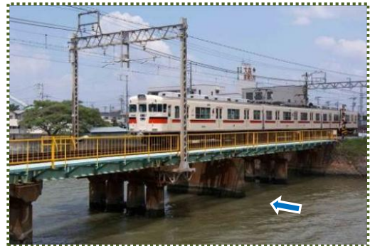
写真-11 山陽電鉄 洗川橋梁
