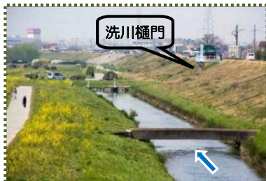
写真-3 堤外水路 → 洗川樋門
