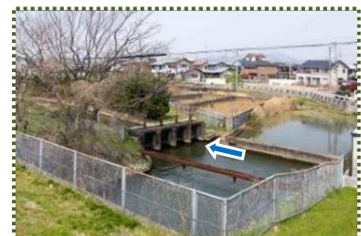
写真-5 洗川樋門の堤内側
