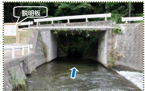
写真-3 切山隧道呑口部
