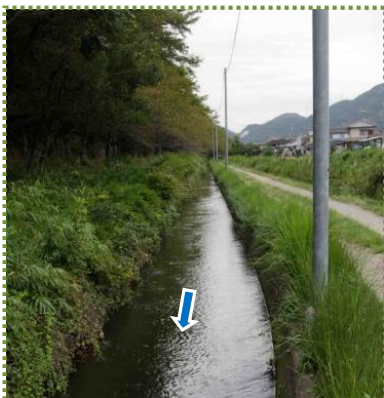
写真-4 山裾を通る導水路
