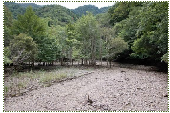
写真-7 ほぼ満砂状態の三川堰堤堆砂敷
