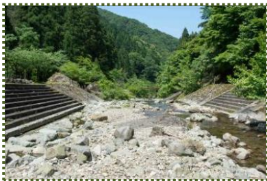
写真-8 階段護岸工
