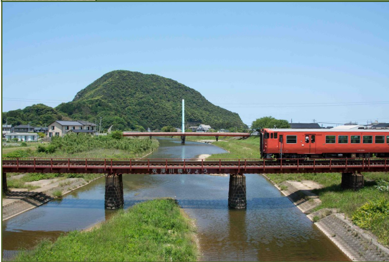
写真-1 佐津川橋から下流を撮影（令和2年5月）
