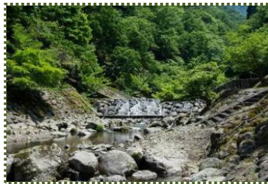
写真-9 床固工と両岸の階段護岸・岩組護岸
