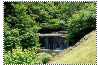
写真-10 事業区間の最上流に設置された砂防ダム
