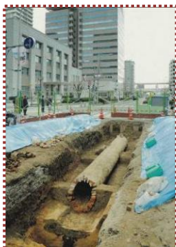
写真-6 京町筋の下水渠発掘現場
