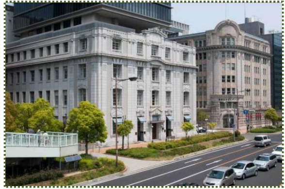
写真-4 メリケン波止場前歩道橋から旧居留地を撮影（平成22年5月） （左：海岸ビル、右：商船三井ビル、手前の道路は国道2号）
