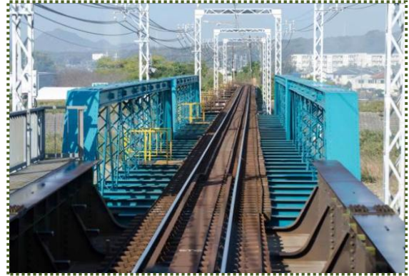
写真-4 トラス桁区間は直線
