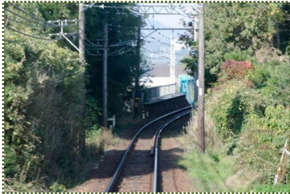
写真-3 手前が耐候性鋼板桁、その向こうがトラス桁
