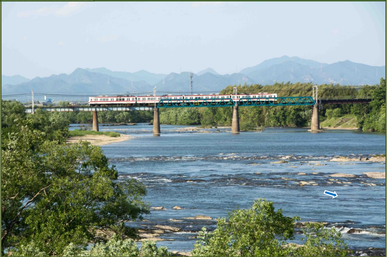
写真-1 神戸電鉄栗生線・加古川橋梁（平成26年5月撮影）
