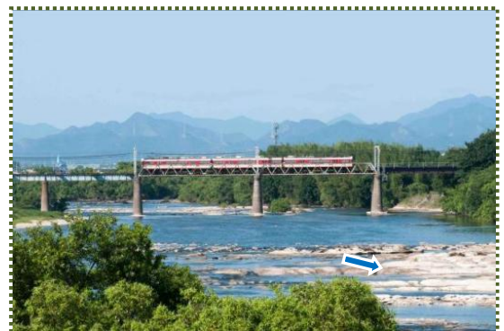
写真-2 神戸電鉄栗生線・加古川橋梁（平成24年8月撮影）
