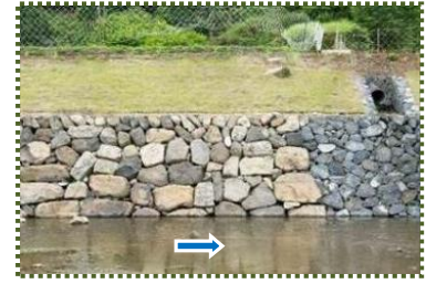
写真-15 左側が石垣を再利用した護岸
