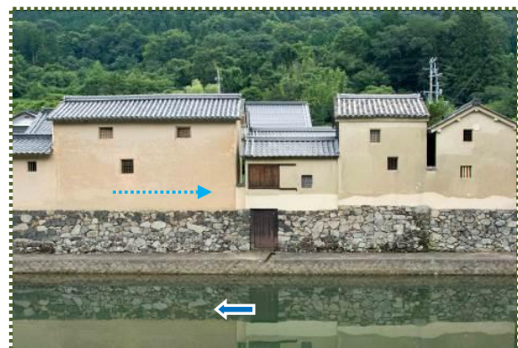
写真-9 土蔵壁に残る洪水痕跡 (平成 26 年 7 月)
