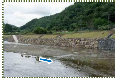
写真-14 出土した石垣を護岸に再利用
