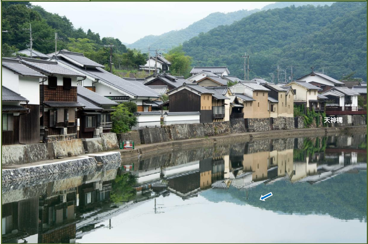
写真-1 平福の川端風景（平成26年7月撮影）
