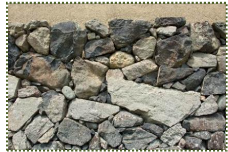
写真-3 土蔵基礎の空石積
