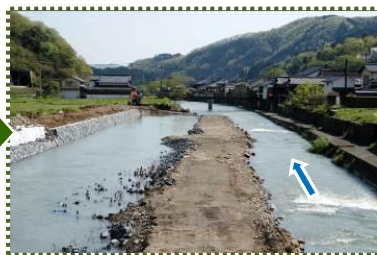
写真-11 工事中(平成25年4月撮影)
