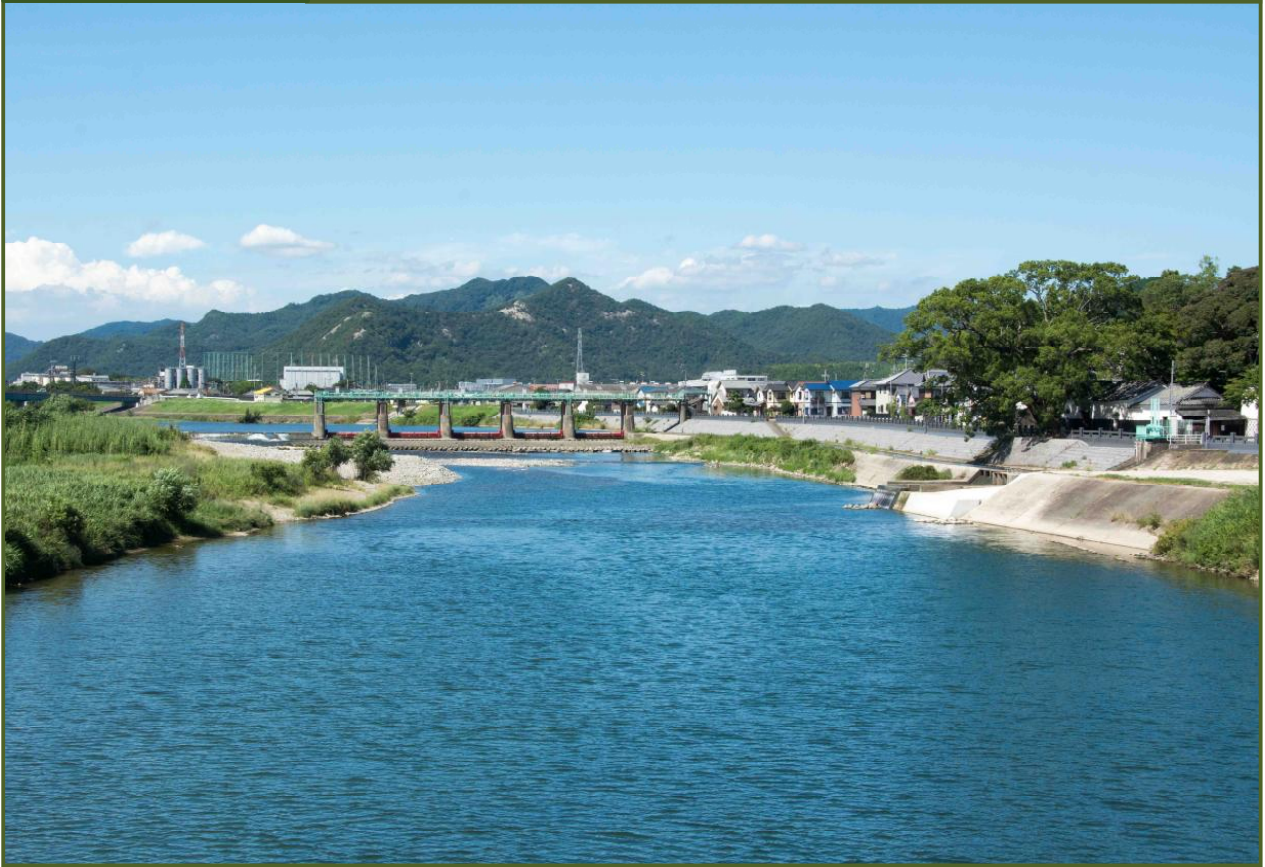
写真-1 旭橋から岩浦頭首工を撮影（令和元年8月）
