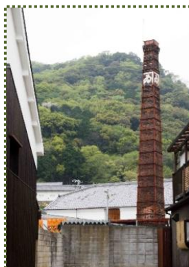
写真-3 カネ中醤油の煙突
