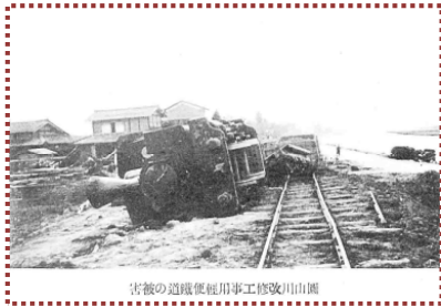
写真-4 円山川改修工事用軽便鉄道の被害
