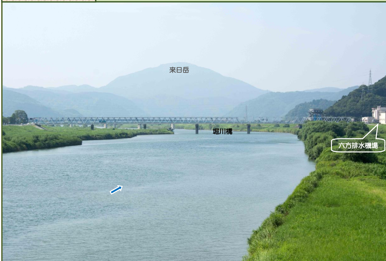
写真-1 立野大橋から円山川下流を撮影（平成27年7月）
