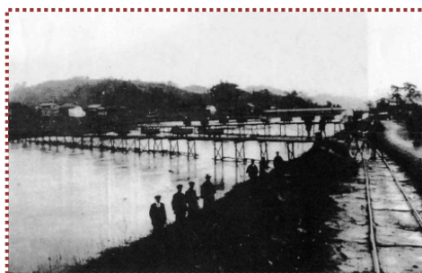
写真-3 堀川橋北の円山川改修工事現場において レールを敷設しトロッコで運搬(『豊岡市史』から引用)
