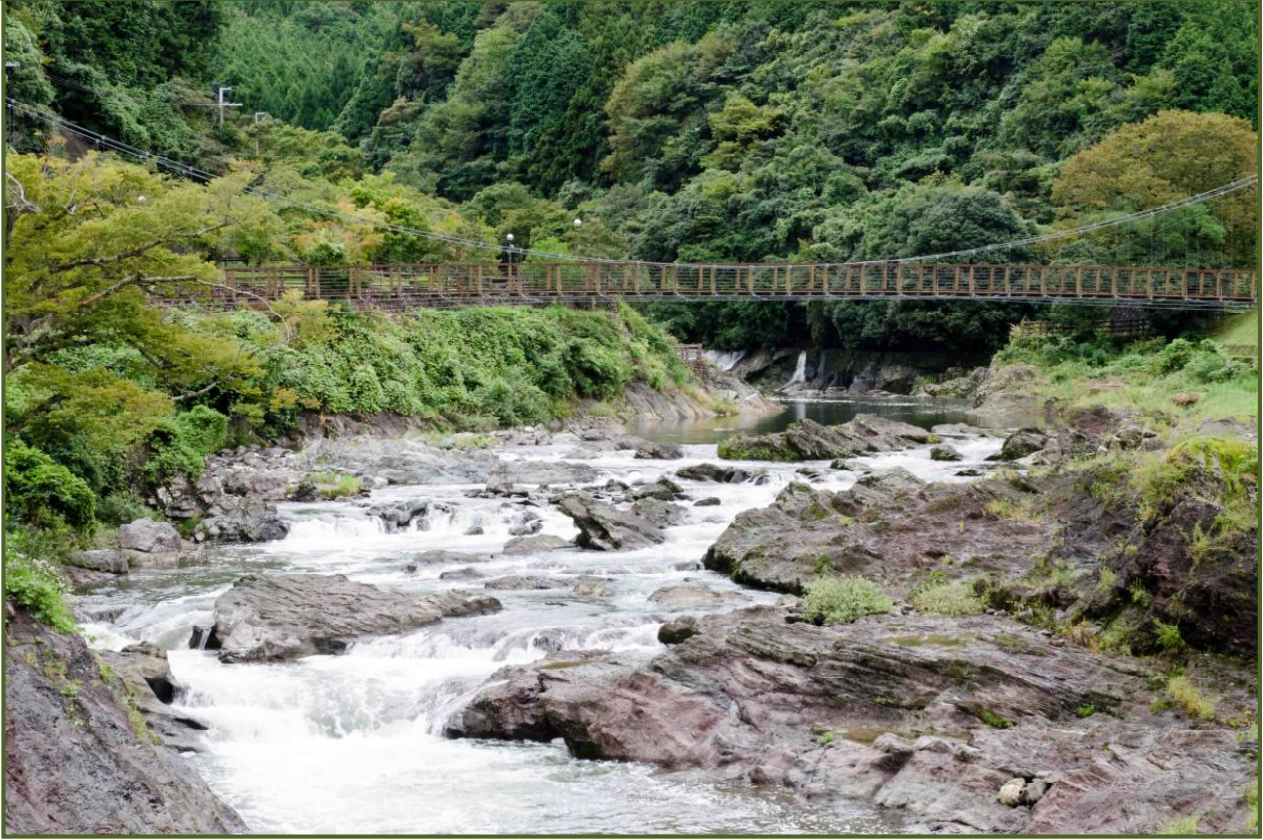
写真-1 川代溪谷に架かる吊り橋（平成23年9月撮影）
