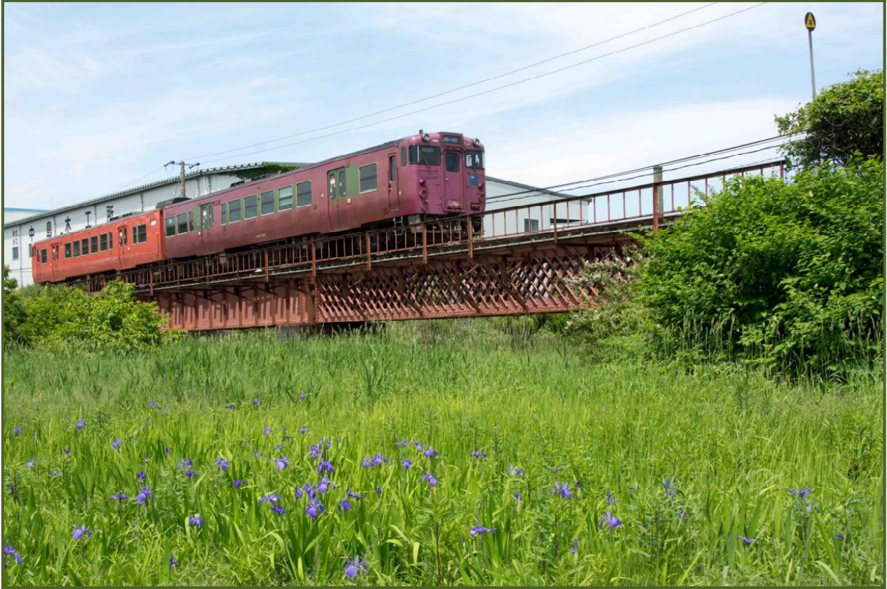
写真-1 JR山陰本線・田君川橋梁のラティス桁（平成27年5月撮影）
