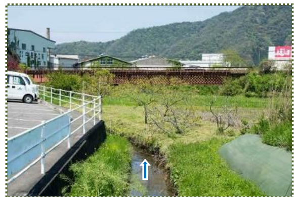
写真-5 用水路(旧田君川)前方に田君川橋梁
