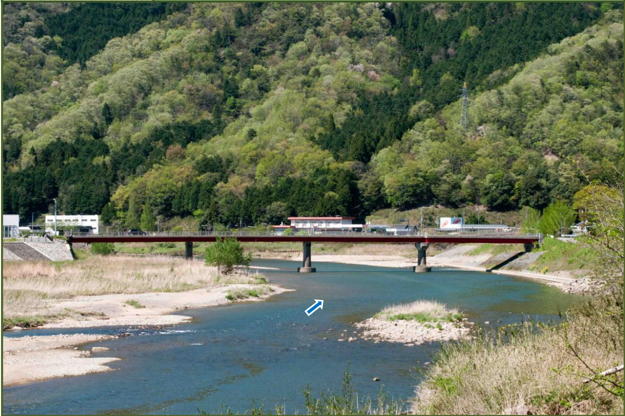
写真-1 円山川に架かる米地橋（平成24年4月撮影）
