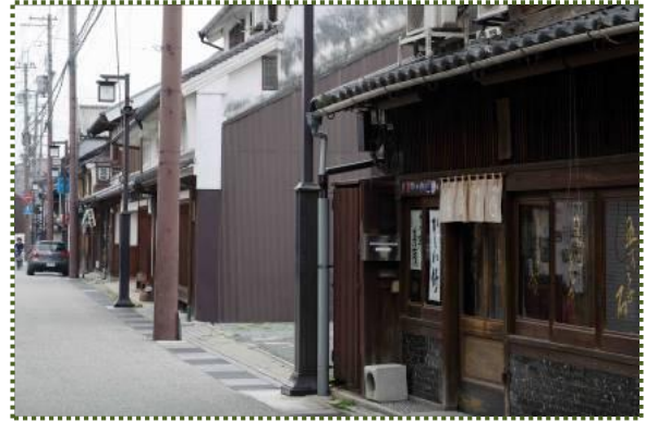
写真-4 龍野町下川原の町並み
