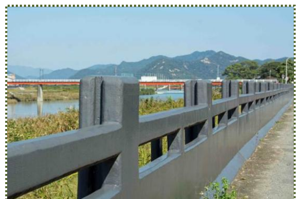
写真-7 龍野橋左岸上流の畳堤 (前方の赤い桁は旭橋)
