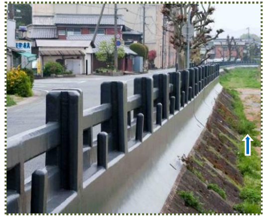
写真-8 旭橋下流左岸の畳堤
