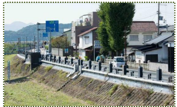
写真-9 旭橋から右岸の畳堤を撮影（道路は国道179号）
