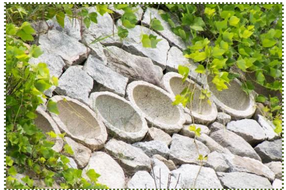
写真-12 貯水池法面に並べられた石臼
