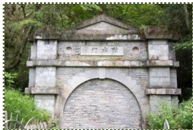
写真-7 本流放水路の扉門（「放水門」と刻字）
