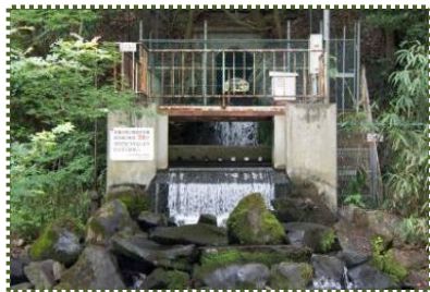
写真-2 分水堰堤で取水した水の吐口
