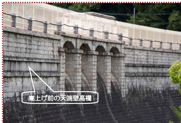
写真-8 立ヶ畑堰堤嵩上げの跡
