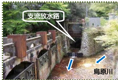
写真-6 締切堰堤（3門の鑄鉄製ゲート）
