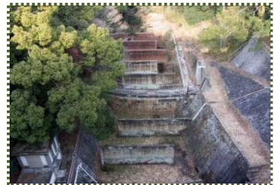
写真-4 堰堤直下の沈澄池
