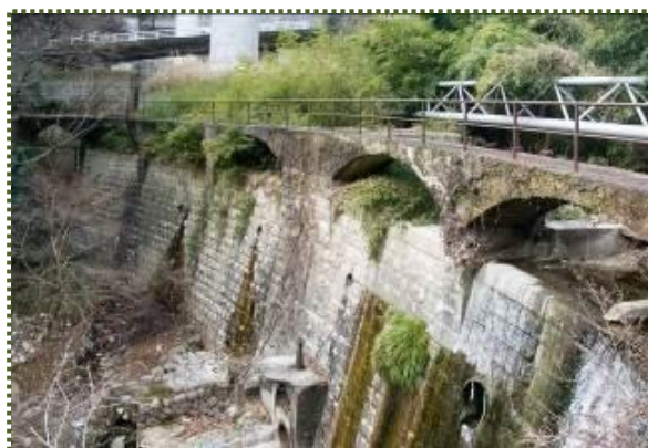
写真-10 天王水源取水堰堤 (平成 28 年 1 月撮影)
