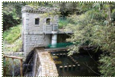
写真-3 烏原川分水堰堤と覆屋
