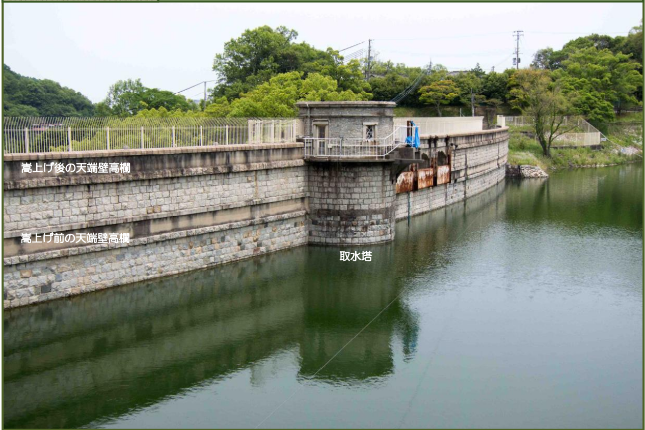
写真-1 立ヶ畑堰堤（平成25年6月撮影）
