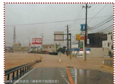
写真-2 洲本川の溢水状況（洲本市下加茂付近） （「洲本川水系河川改修事業」パンフから引用）
