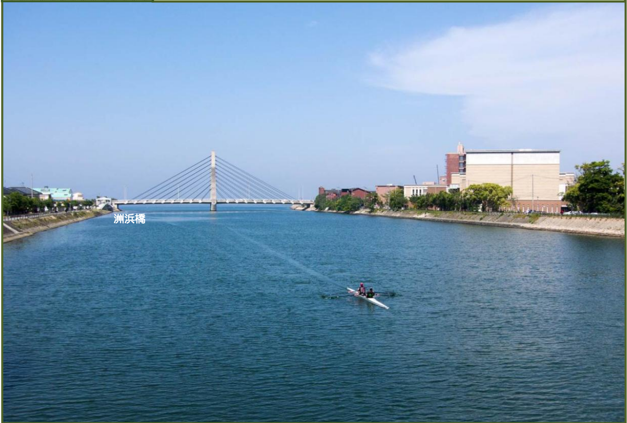
写真-1 洲本橋から洲浜橋を撮影（平成 25 年 5 月）
