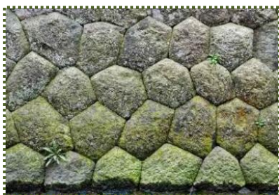
写真-9 亀甲積み
