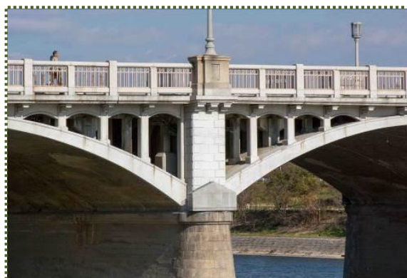
写真-5 武庫川に架かる開腹構造の国道2号・武庫大橋
