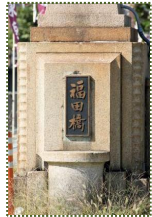
写真-7 左岸下流：「福田橋」
