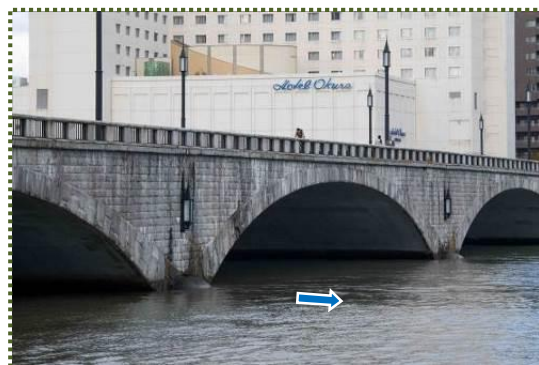
写真-3 信濃川に架かる充腹構造の万代橋
