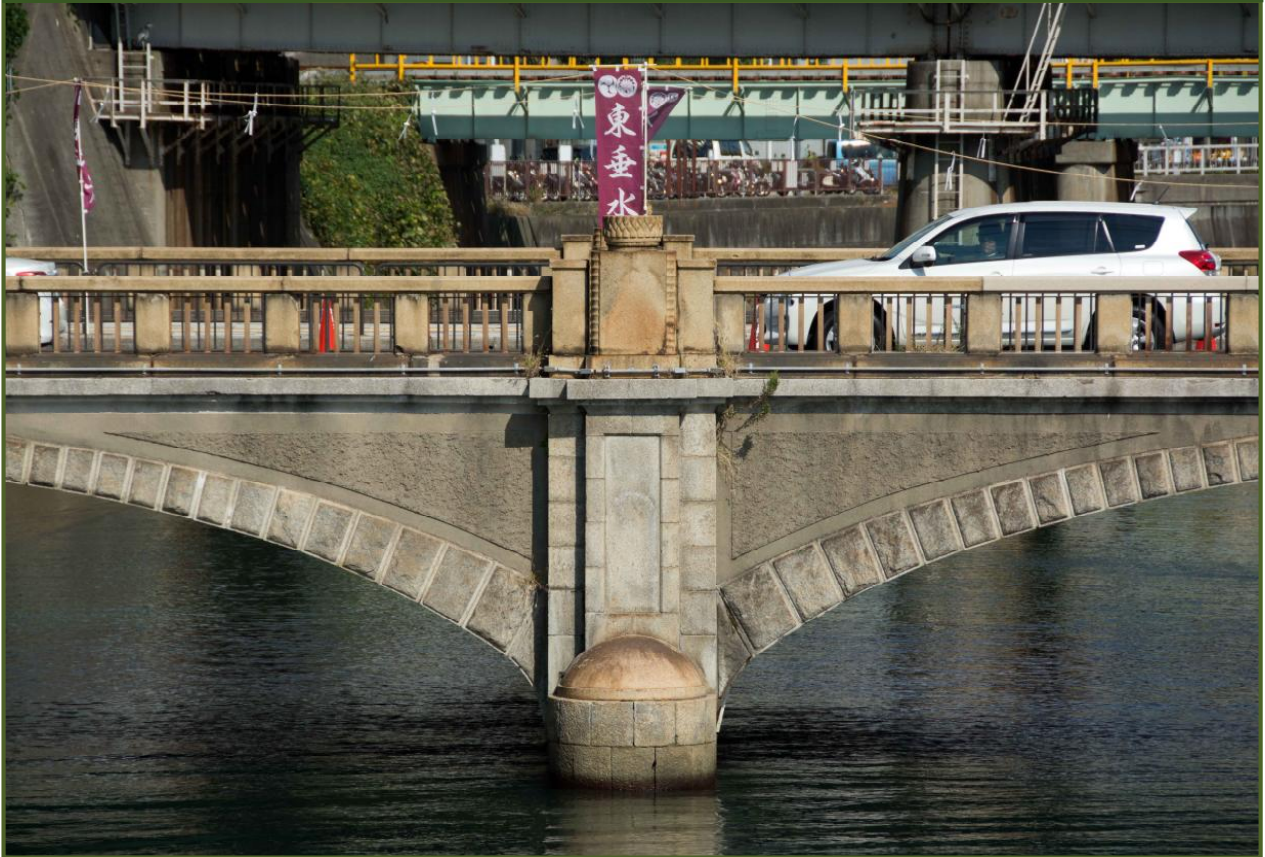
写真-1 国道2号・福田橋（平成27年10月撮影）
