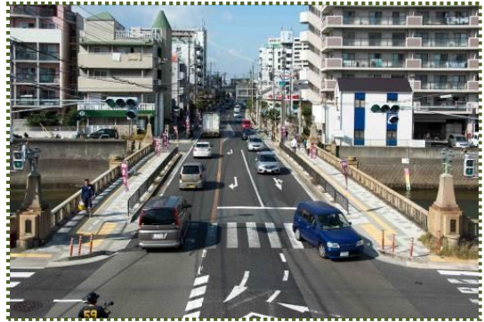
写真-6 福田橋東の歩道橋から福田橋を撮影
