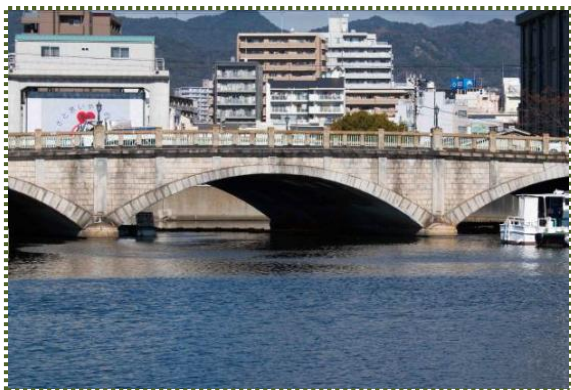
写真-4 新川運河に架かる充腹構造の大輪田橋
