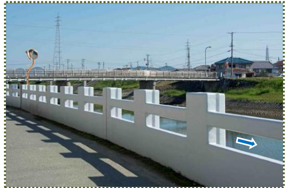
写真-10 元川橋下流から畳堤を撮影
