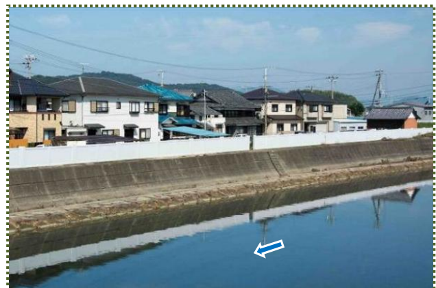
写真-11 元川橋から右岸上流のパラペット堤を撮影
