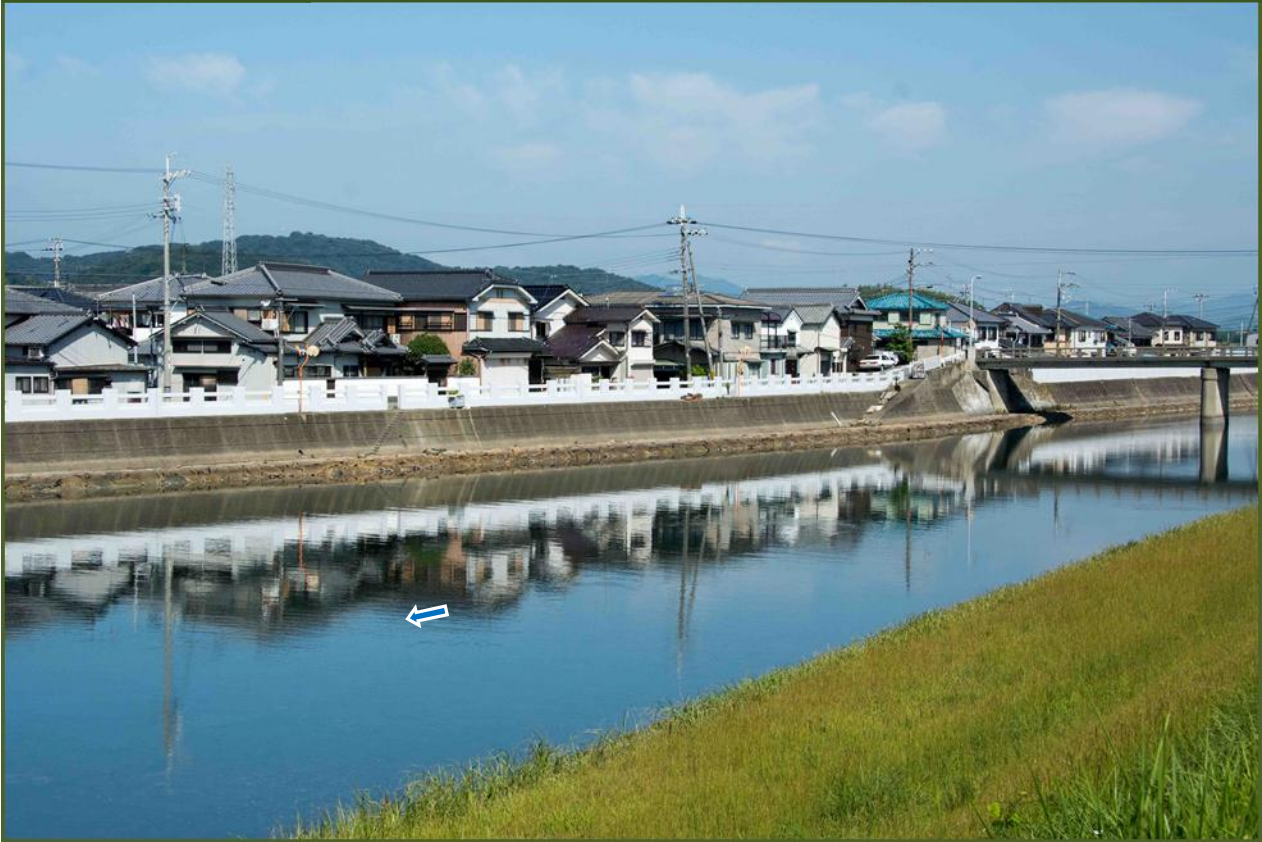
写真-1 元川左岸から対岸の畳堤を撮影（平成29年9月）
