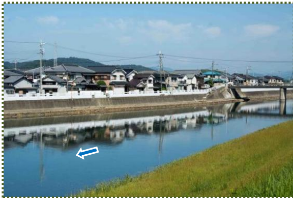
写真-7 元川左岸から右岸の畳堤を撮影
