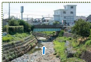
写真-13 国道2号 喜瀬川橋
