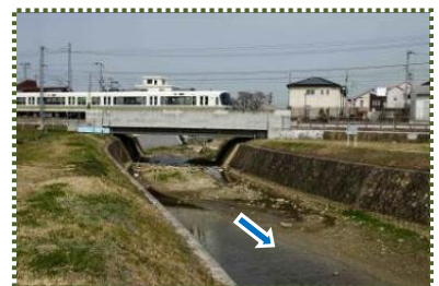
写真-14 JR山陽本線・喜瀬川橋梁
