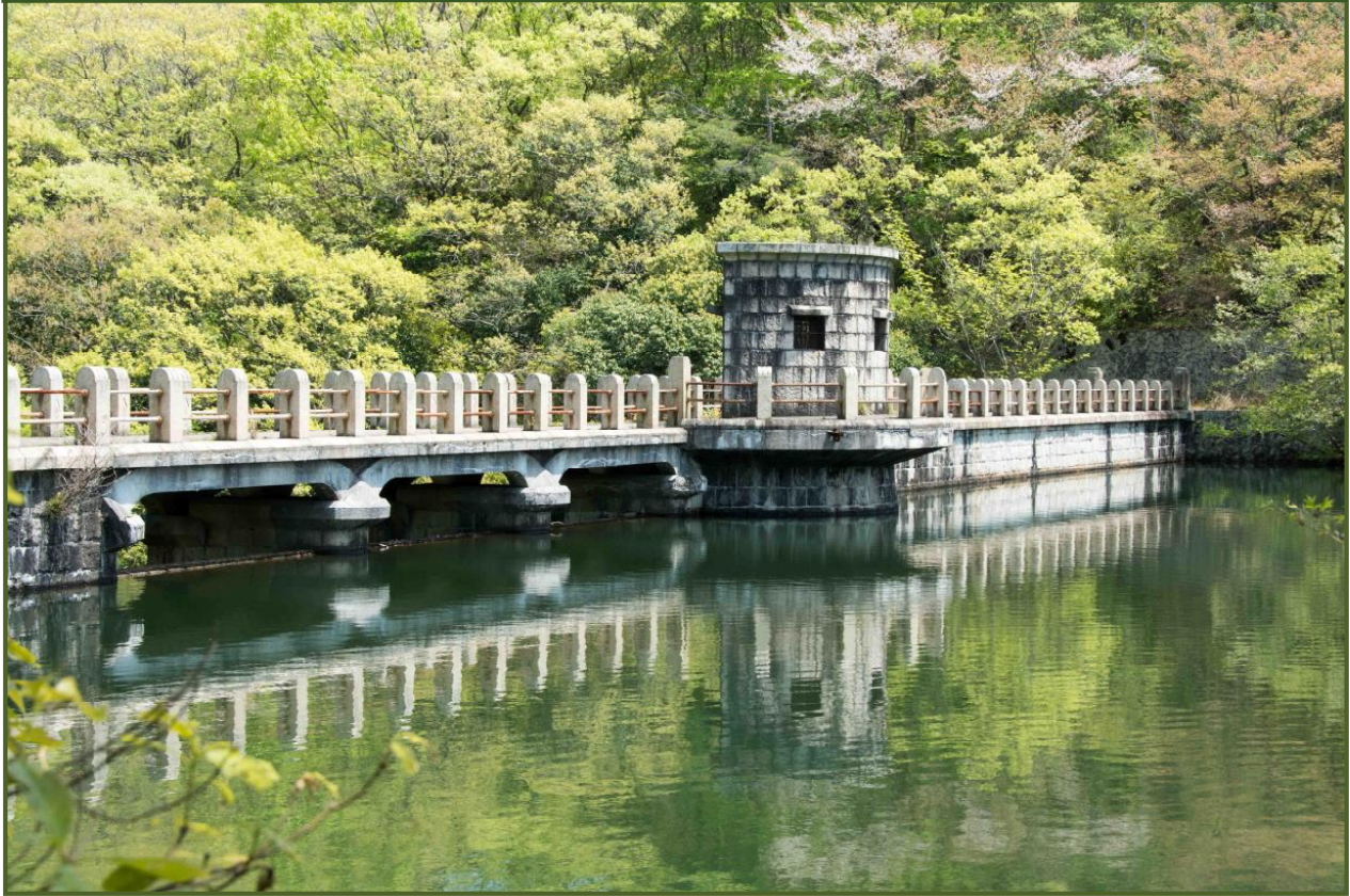
写真-1 山田池堰堤の洪水吐と引水塔（令和2年4月撮影）
