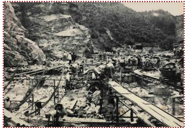
写真-4 昭和5年9月 床掘部粗石モルタル埋め戻し済
