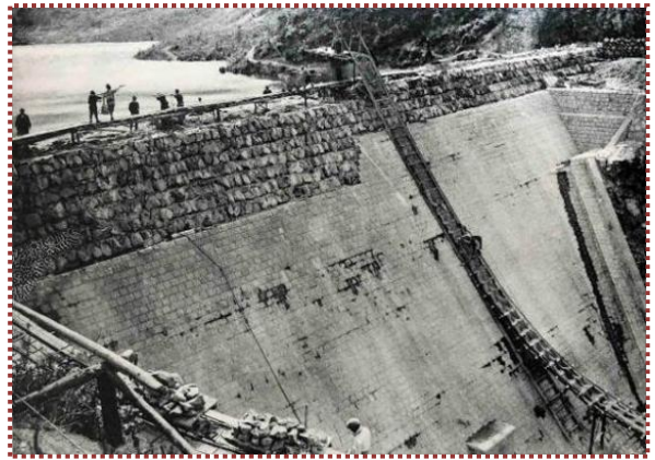
写真-14 昭和7年3月下流から撮影 築堤出来高平均55尺
