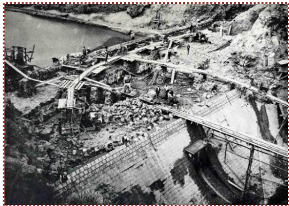
写真-8 昭和6年3月下流から撮影 築堤出来高平均 15 尺
