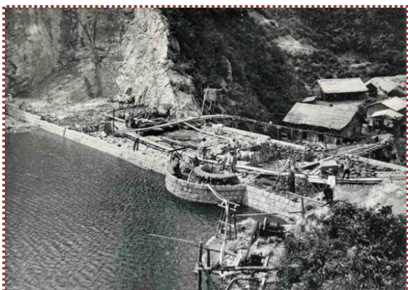
写真-9 昭和6年6月上流から撮影 築堤出来高平均 25 尺
