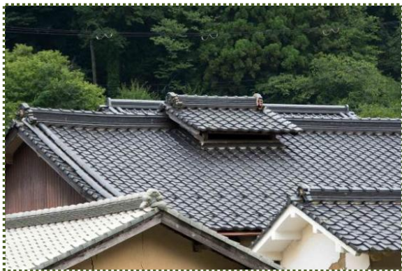
写真-11 越屋根のある民家
