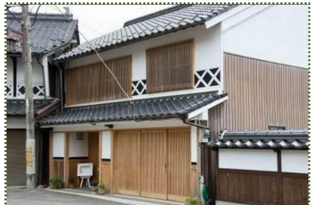
写真-16 修復後の町家
