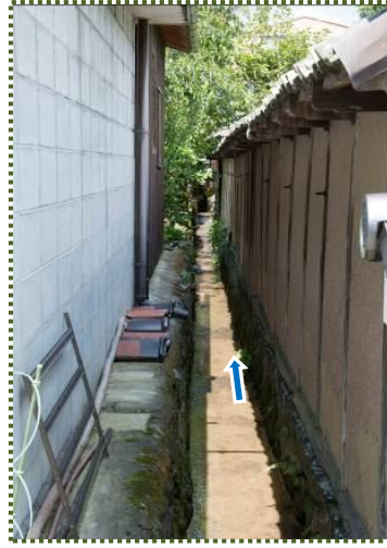
写真-6 背割下水路
