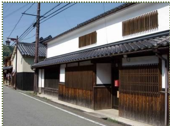
写真-15 修復後の町家
