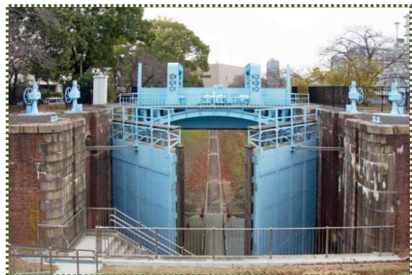
写真-12 淀川大堰の左岸部に残る毛馬閘門
