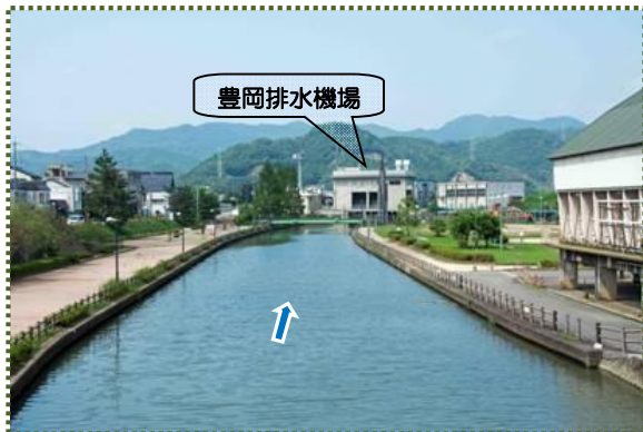
写真-3 戸牧川（立野橋から下流を望む）
