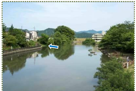
写真-8 大磯川（国道312号京口橋から東を望む）
