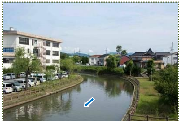
写真-5 大磯川（戸牧川合流点上流）
