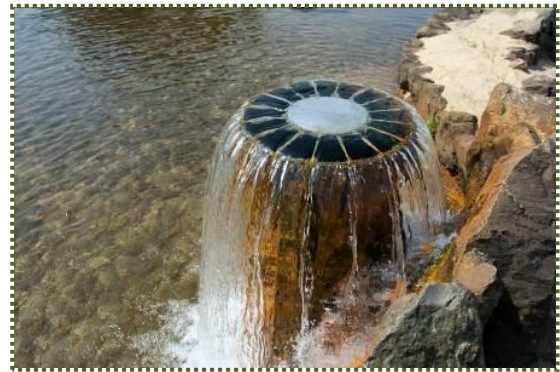
写真-3 管周辺の鉄さびの付着状況 (第1自噴泉)
