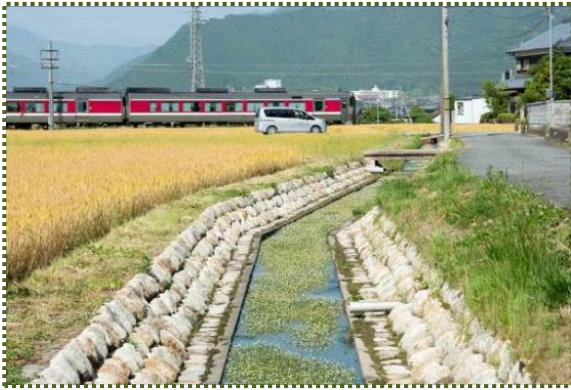
写真-10 バイカモが群生する用水路（JR播但線「はまかぜ」が通過中）
