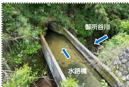
写真-4 御所谷川を越える水路橋
