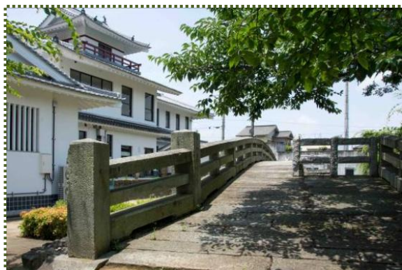
写真-16 左の城郭風の建物は姫路市東出張所（御国野公民館）
