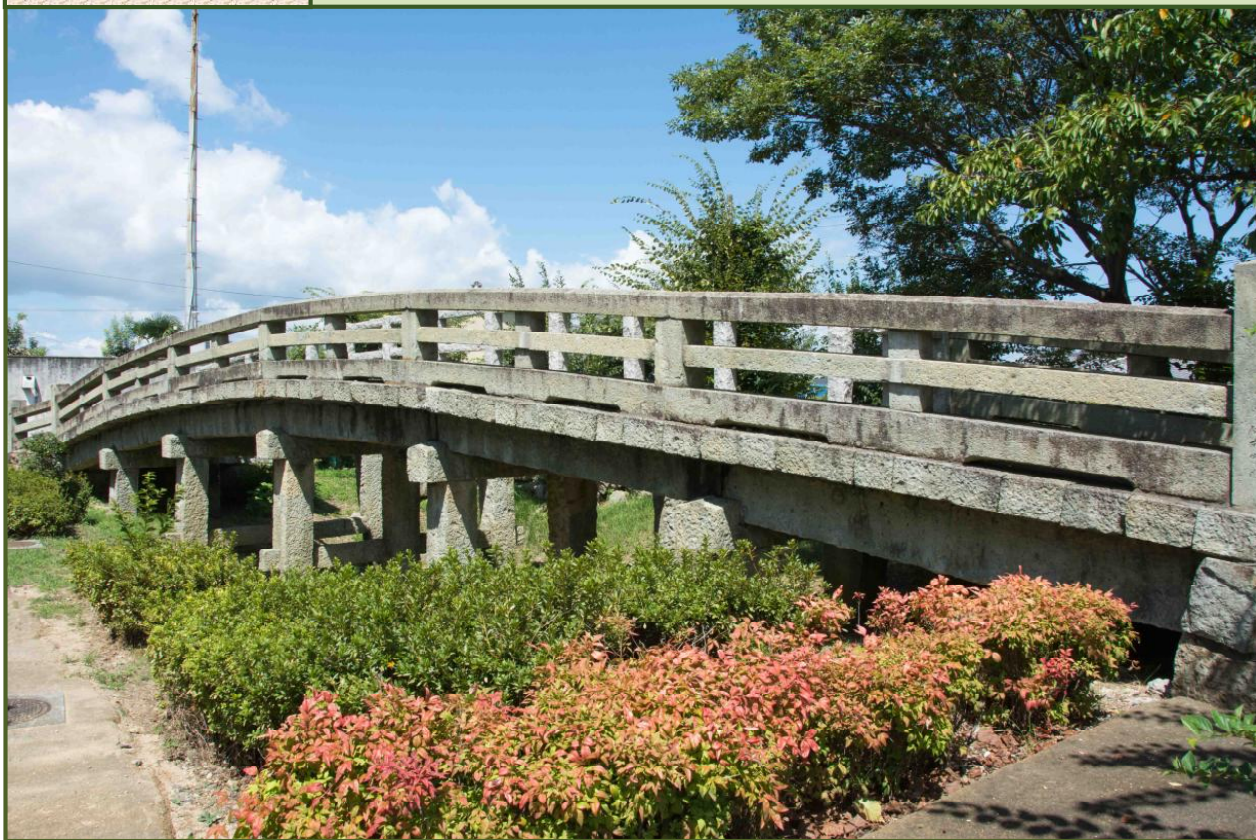
写真-1 御着城濠跡に移築・保存されている天川橋（平成 29 年9月撮影）
