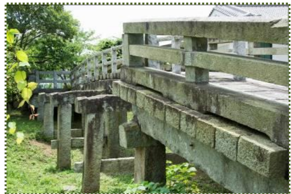
写真-15 落橋した中央部は橋脚だけが復元されている
