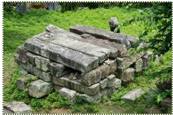
写真-19 落橋した中央部の石材
