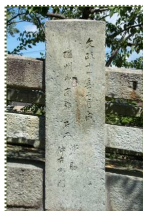
写真-5 親柱の南面
