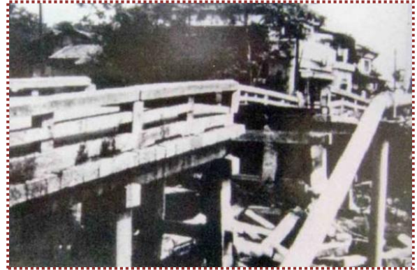
写真-13 昭和 47 年 9 月の洪水で落橋した旧天川橋 （姫路みなとミュージアム展示写真から引用）
