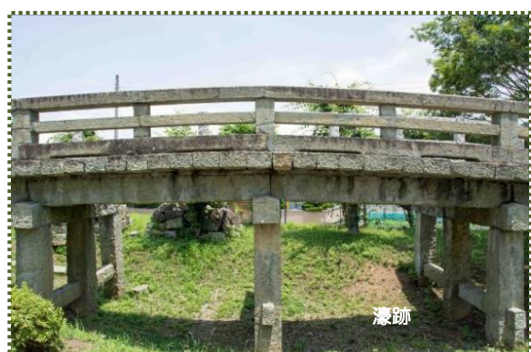
写真-17 天川橋の中央部分
