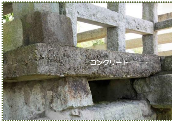
写真-18 コンクリート製に置き換えられた部材
