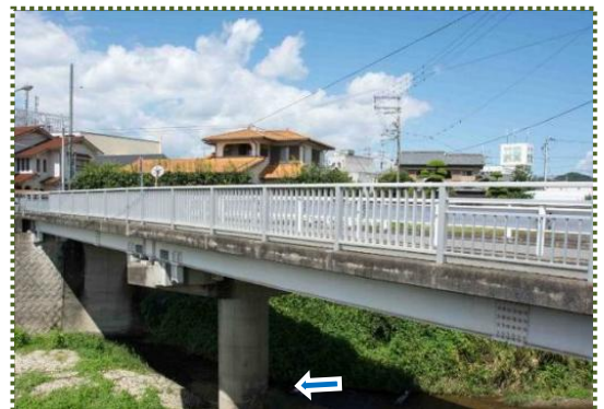
写真-9 現・天川橋
