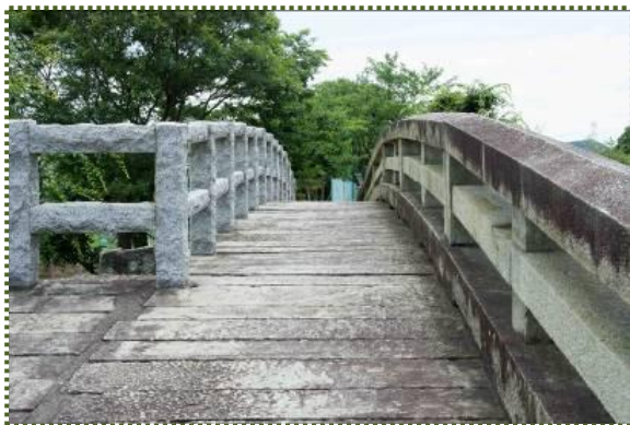
写真-14 落橋した中央部を狭くして復元
