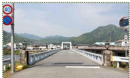
写真-3 屋形橋（左岸側から撮影）
