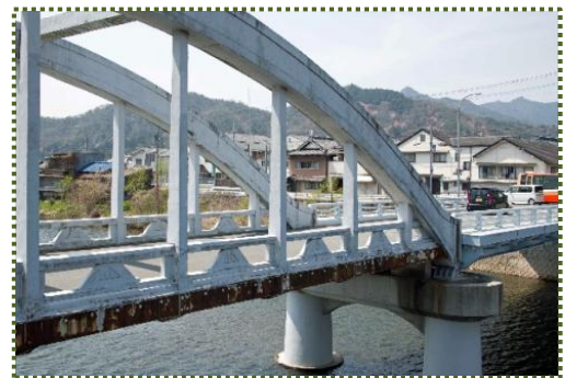
写真-7 屋形橋のアーチ部
