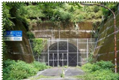
写真-4 鐘ヶ坂トンネル
