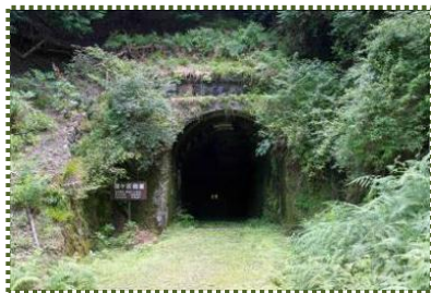
写真-3 鐘ヶ坂隧道
