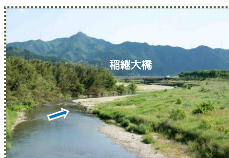
写真-2 本郷橋から佐治川下流を撮影（令和元年5月）
