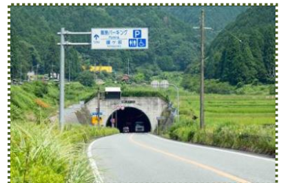
写真-5 新鐘ヶ坂トンネル
