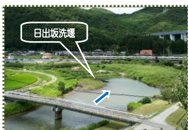
写真-15 武庫川・日出坂洗堰の上流部
