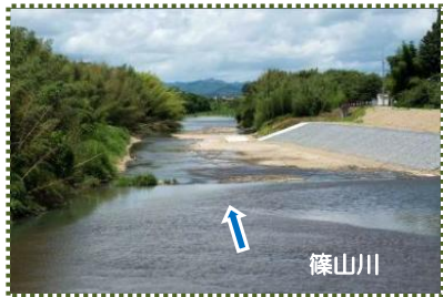
写真-6 泉橋から下流を望む
