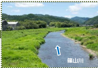
写真-7 北嶋橋から下流を望む
