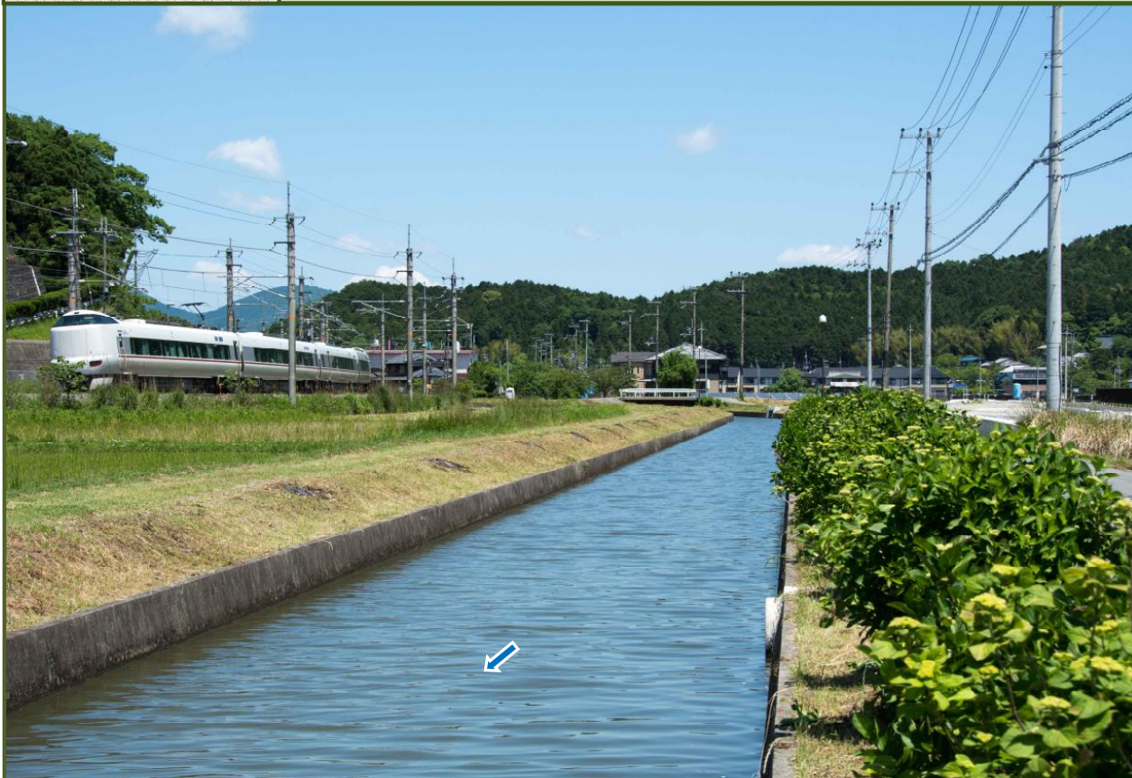
写真-1 JR 福知山線に沿って流れる田松川（平成27年5月撮影）
