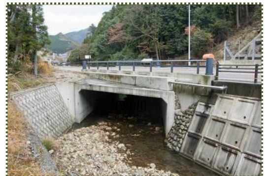
写真-11 鐘起橋という名称のボックスカルバート
