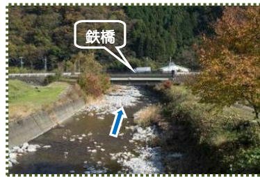
写真-9 田路川 (中島橋から下流を望む)
