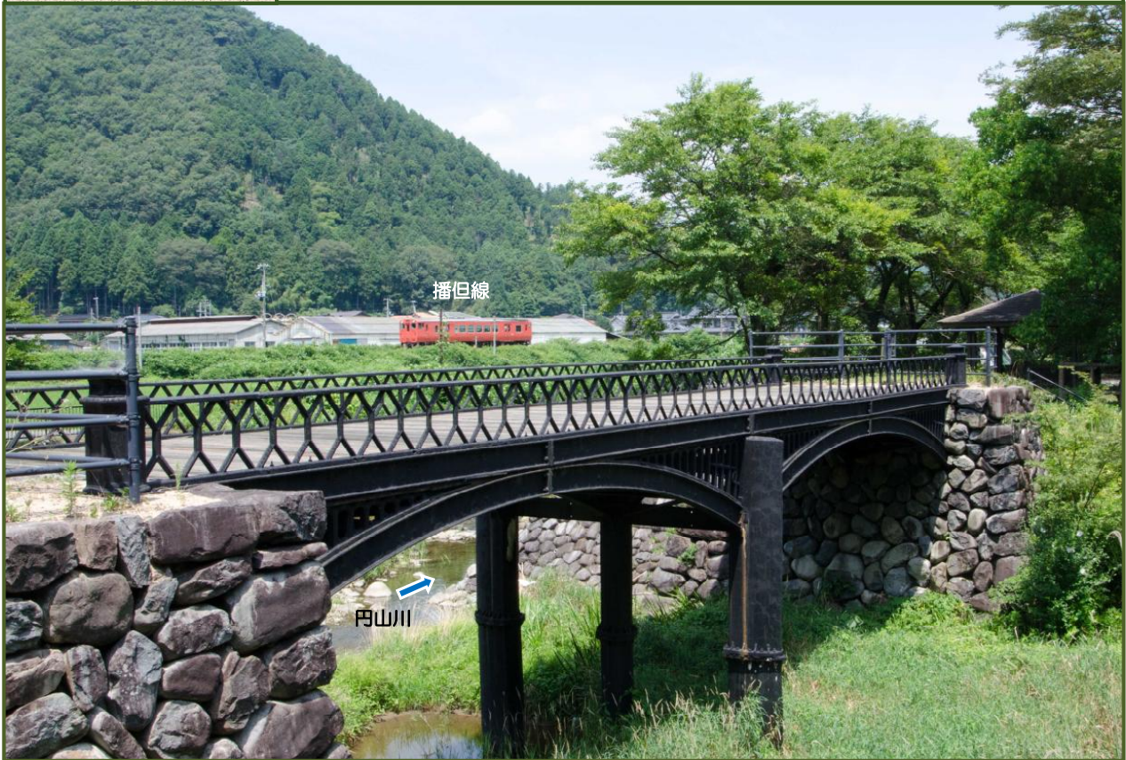
写真-1 国道312号沿いに移築・保存されている羽瀧鉄橋（平成25年7月）
