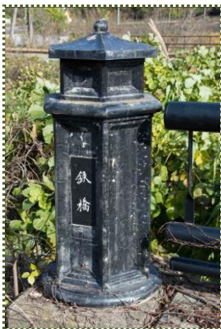
写真-4 「鉄橋」の親柱
