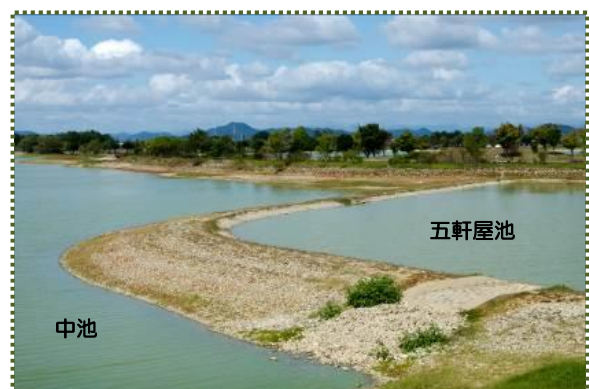
写真-10 中池と五軒屋池を仕切っていた堤防
