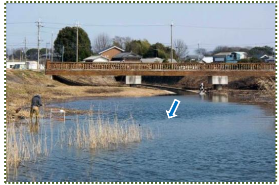
写真-5 加古大溝（加古大池への流入部）
