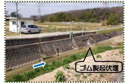
写真-8 草谷川 河原田井堰
