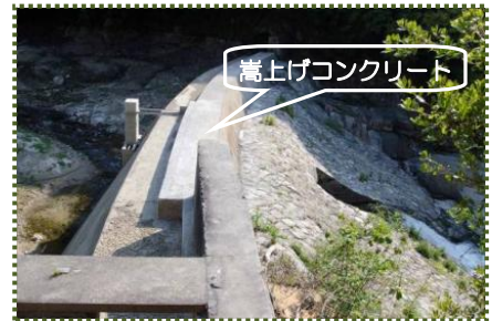
写真-8 川池堰堤 右岸天端から左岸方向を見る
