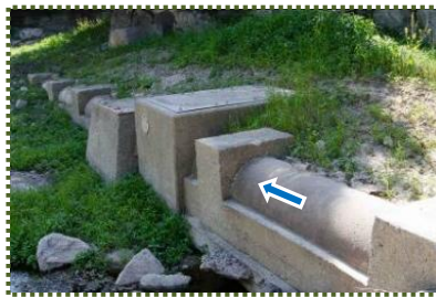
写真-12 川池の右岸沿いに設けられた導水路
