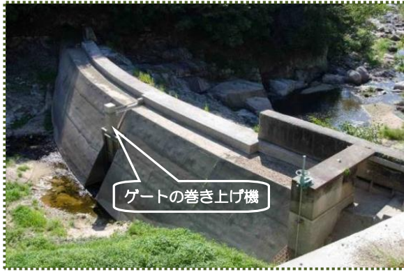
写真-9 堤体の上流面は漏水防止のための張コンクリート
