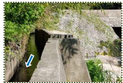
写真-13 堰堤右岸下流の用水路
