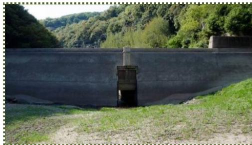
写真-7 川池堰堤の上流面
