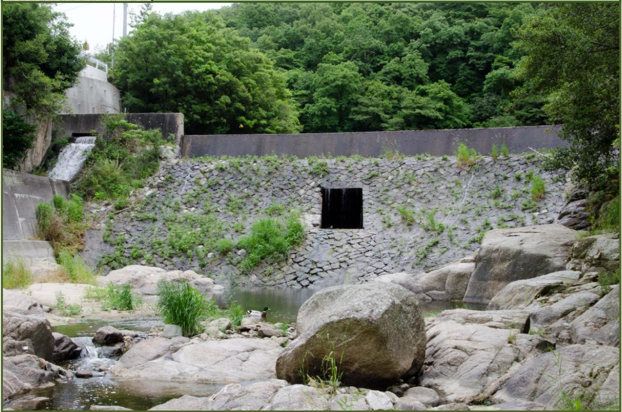
写真-1 川池堰堤（平成25年5月撮影）
