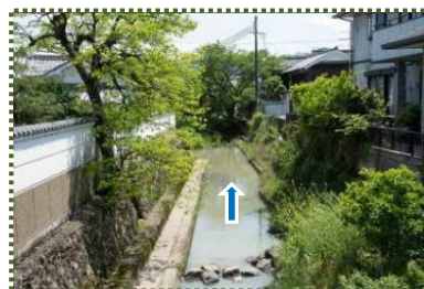
写真-9 門前橋下流の黒岡川護岸の根継工
