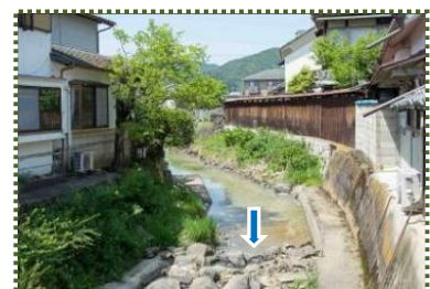
写真-10 門前橋上流の黒岡川護岸の根継工
