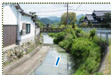
写真-8 小川橋上流の黒岡川護岸の根継工
