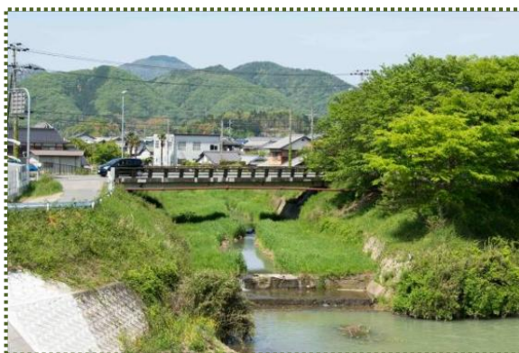
写真-2 篠山川への合流点付近に架かる新開橋
