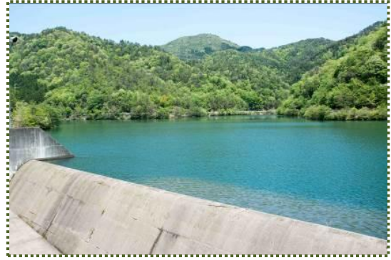
写真-16 藤岡ダム
