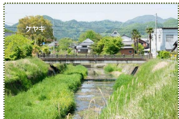
写真-3 旧黒岡川は、新町橋右岸のケヤキの木村近から直角に曲がっていた
