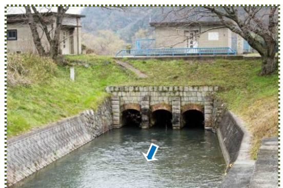
写真-4 船場川の上流端にある飾磨樋門
