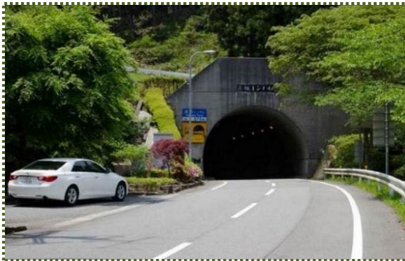
写真-4 高坂トンネル多可町側入口
